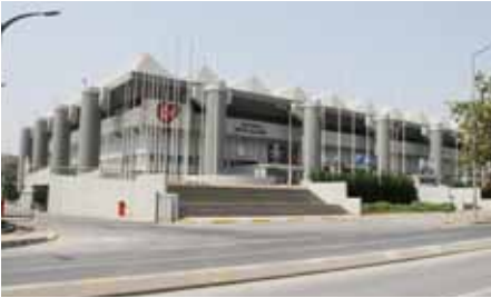
Capacity / Kapasite: 12500 Year of Construction / Yapım Yılı: 1986 Address / Adres: 10. Yıl Cad. Kazlıçeşme / İstanbul
