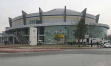
Capacity / Kapasite: 7200 Year of Construction / Yapım Yılı: 2008 Address / Adres: Kadir Has Cad. No:5 / Kayseri
