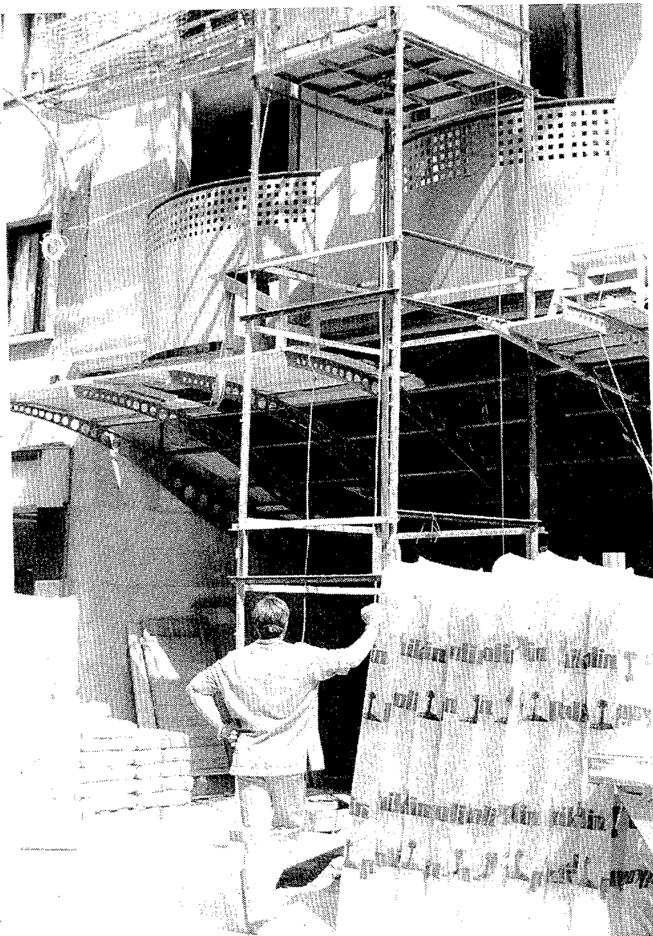
A todo tren • Las obras del Hotel Viena se han intensificado para que el 'dream team' pueda dormir en sus habitaciones. Los colchones ya están a punto • FOTO: GEMMA GÓMEZ
